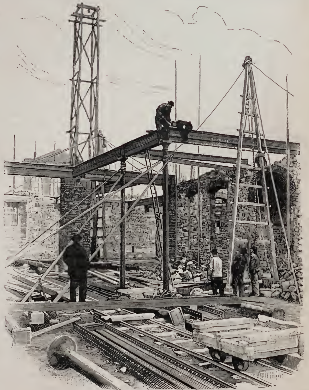
LES CHANTIERS DES CHAMPS-ÉLYSÉES. — Pose des planchers.
